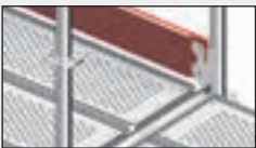
Ahşap süpürgelik montajı
