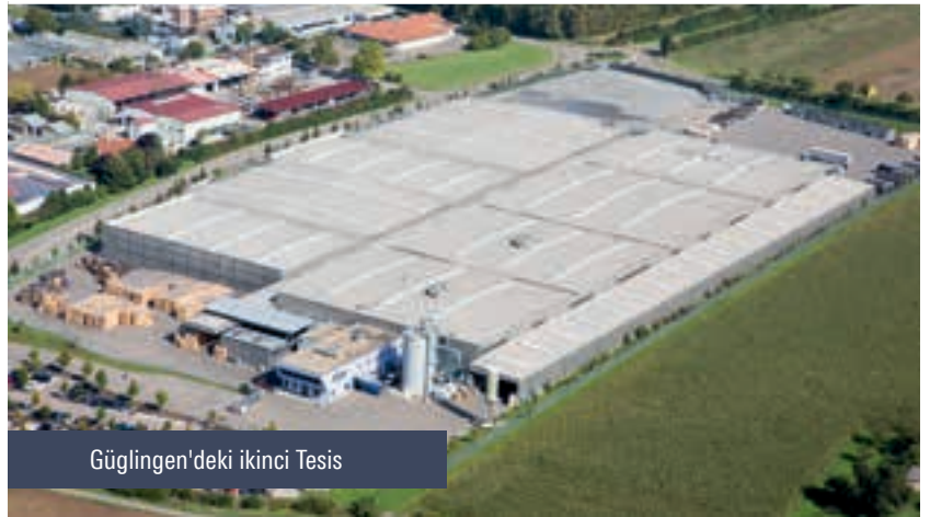
Eibensbach Merkez Tesisi
